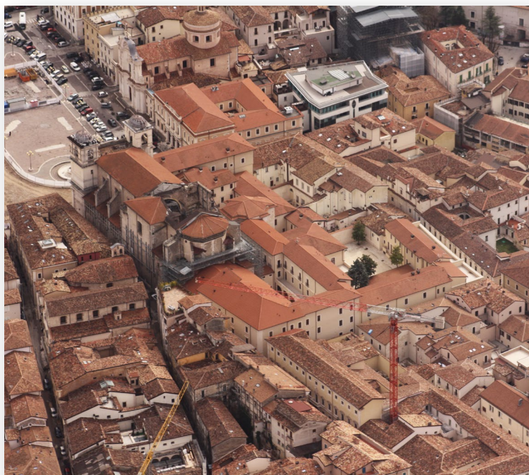
2023 - I lavori sono ufficialmente iniziati a fine febbraio
