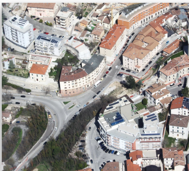
2023 - Il ponte è stato abbattuto ed ancora da ricostruire
